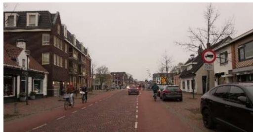
Figuur 6.2 Fietsstrook in asfalt en met 1-1 markering op de Meerndijk
